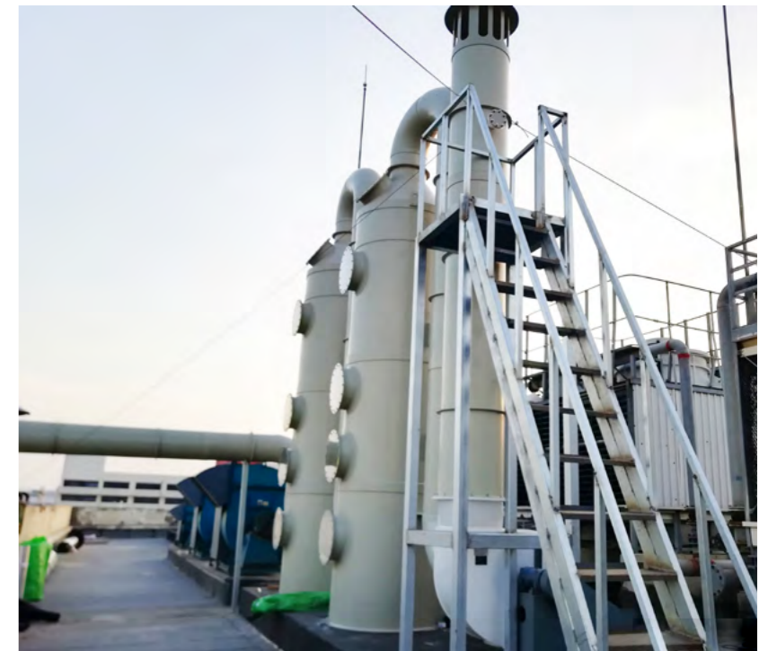
脱硫脱硝处理设施
