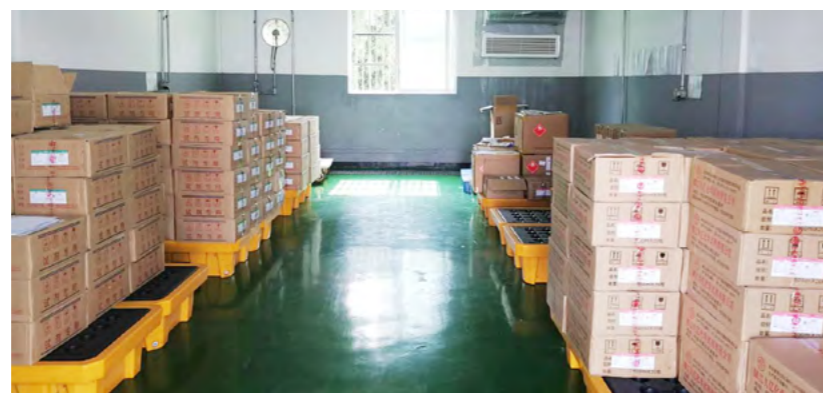
仓库内安装防爆摄像头
