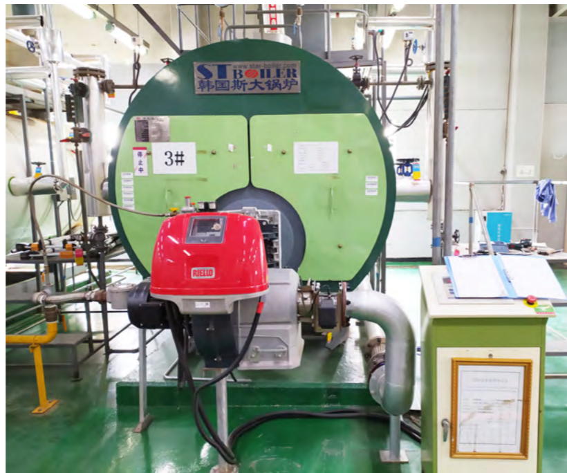
LGD YT 锅炉超低氮燃烧器改造，NO x 排放量由 100ppm 降低至 30ppm，每年减少 NO x 排放约 813.96kg
