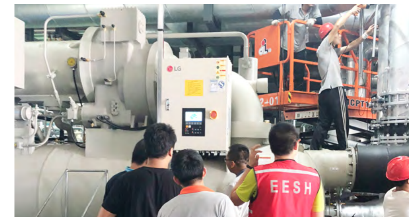
高效制冷机安装
