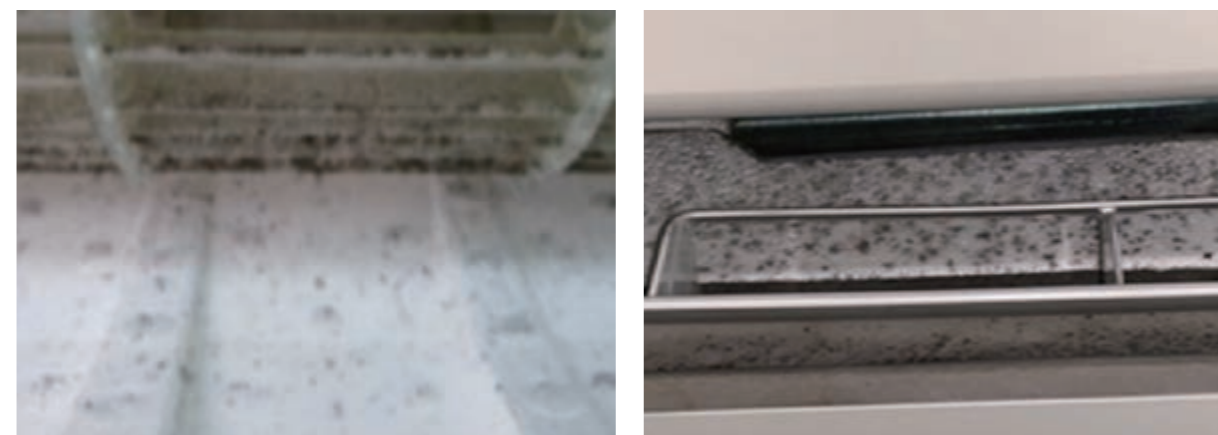
Przykład przypadku zanieczyszczenia EPS.
