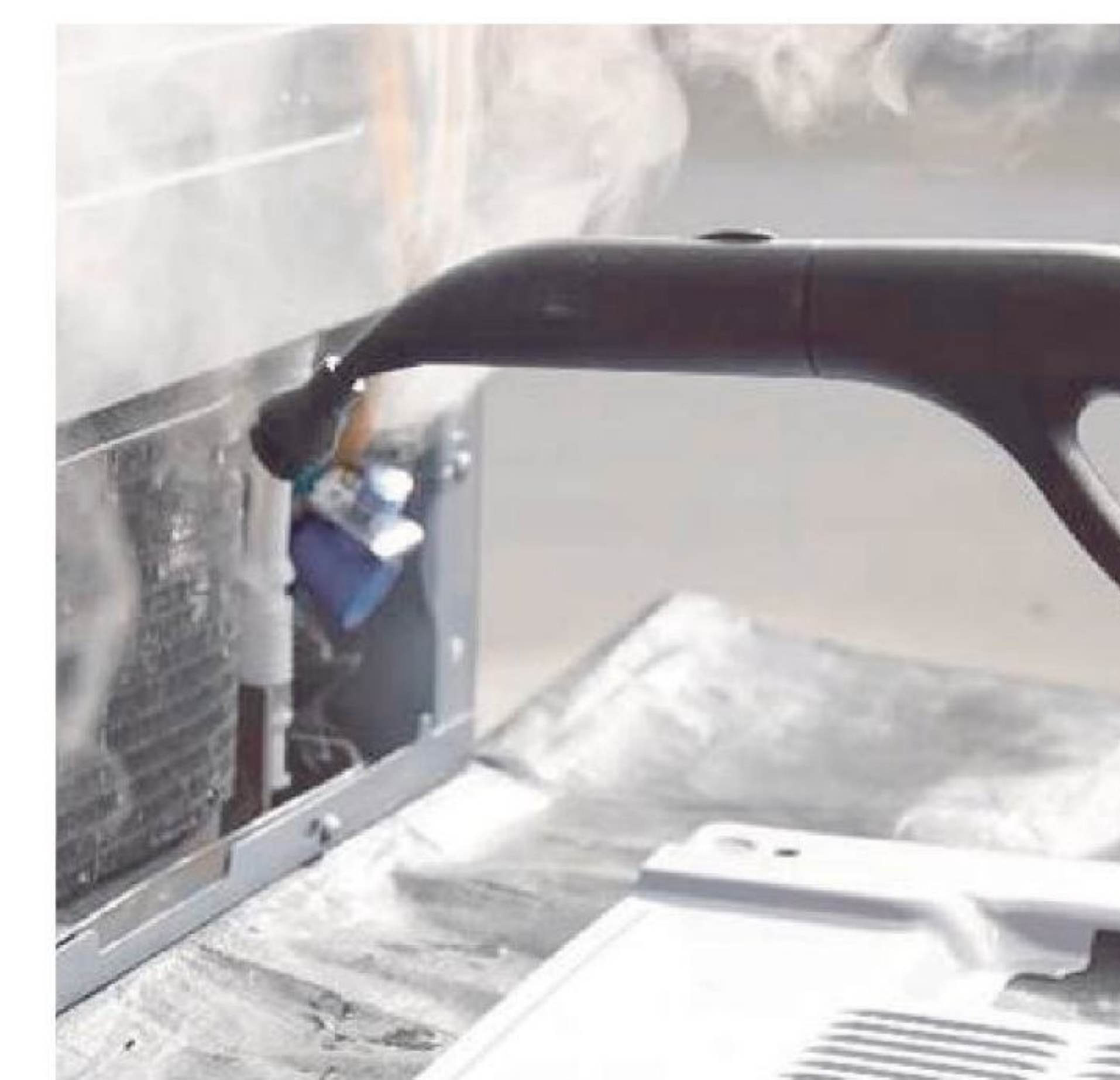
蒸氣清潔冷凝器
