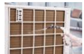
室外機清洗(不拆機) 63
