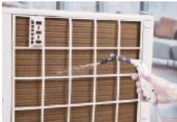
室外機清洗(不拆機) 63
